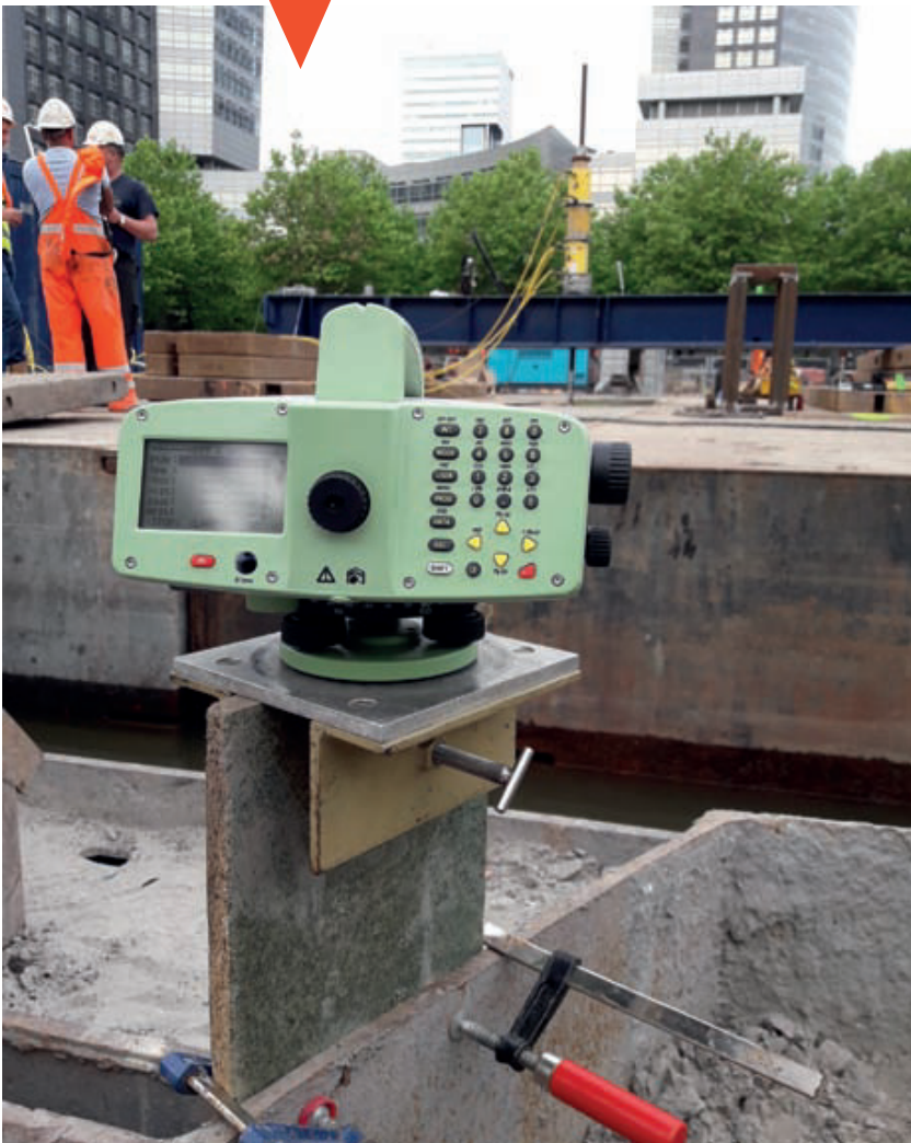
Proefopstelling gezien vanaf het digitale waterpas- toestel
