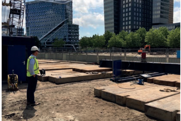
Proefopstelling bezwijkproeven vooraf aan het project
