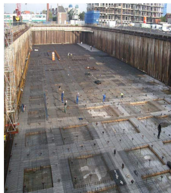
Damwanden, vloeren; ze worden allemaal met grondankers op hun plaats gehouden.
