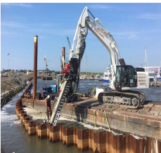
Grondankers zijn niet meer weg te denken bij de aanleg van civiele werken.
